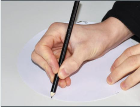
1. Schneiden Sie, wenn Sie eine geeignete Position für die Antenne gefunden haben, die mitgelieferte Schablone aus. Nutzen Sie die Schablone, um die Position der Zentrierbohrung (25 mm Durchmesser) und die Außenseite der Antenne zu markieren.
