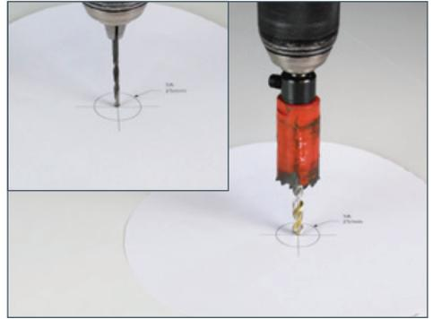
2. Führen Sie am markierten Mittelpunkt eine Führungsbohrung (2,5 mm Durchmesser) durch das Dach durch. Führen Sie die Hauptbohrung mit einer 25mm-Lochsäge durch.
